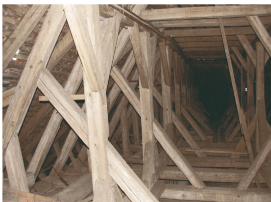
3: Spodní část krovu (postraní stolice s průběžnými rameny krokví)
