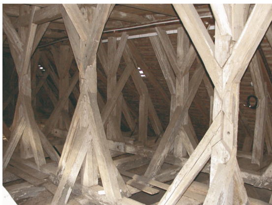
5: Tesařské spoje (jednostranné rybinovité překlátování)
