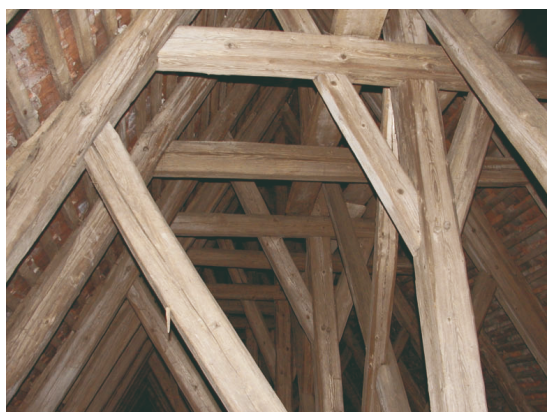
4: Vrchní část krovu (klasové vzpěry, vrchní hambálek, hřebenový sloupek)
